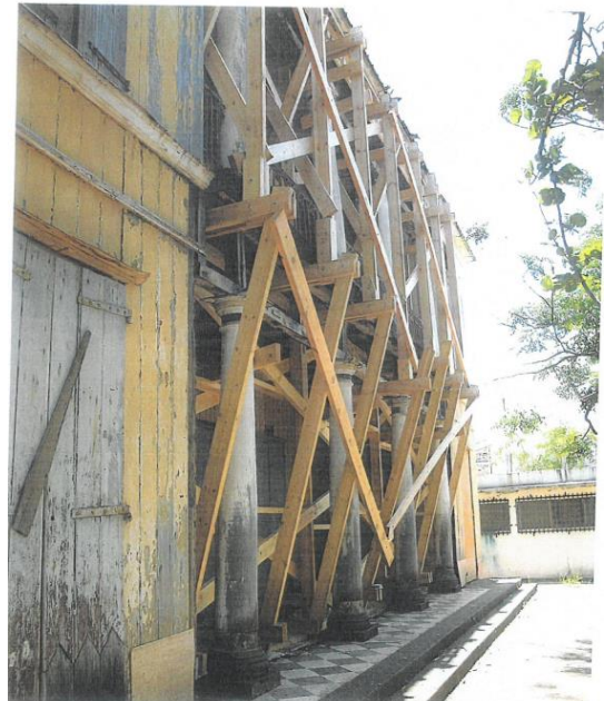
Étaieage d'urgence mise en place par l'entreprise ASSELIN en 2006
